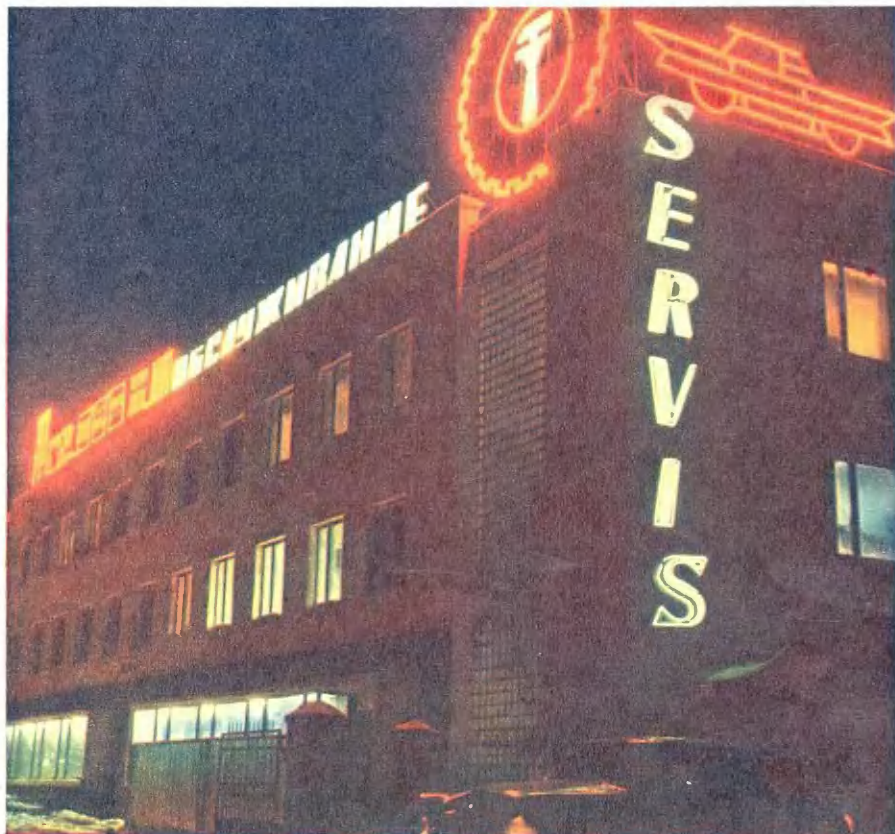
Просторные цехи, производительное оборудование — такими предстают перед нами новые станции технического обслуживания автомобилей. На снимках: одна из таких станций — в Иваново.
